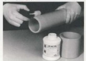
Lösungsmittelklebstoff auf die Außenseite des Rohres auftragen
